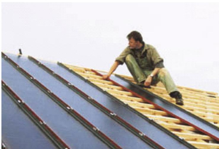
Figure 13 : Montage de panneaux Solartec type Design sur bac acier (modules souples UNISOLAR)
