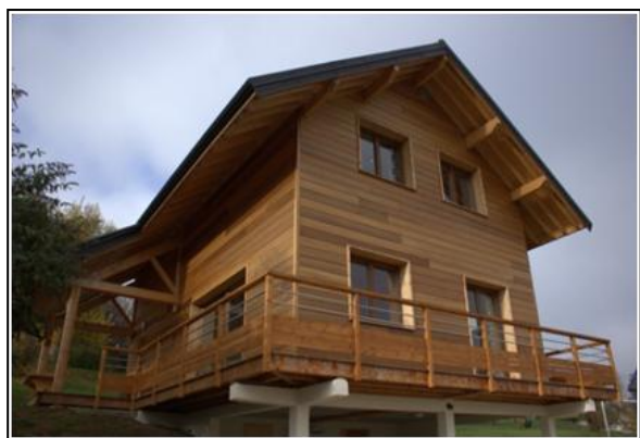
Façades Est et Sud
