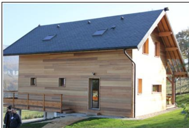
Façades Nord et Ouest
