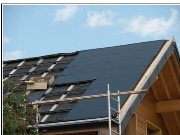
Installation de la toiture photovoltaïque
