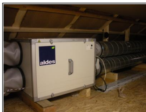
Ventilation Mécanique Contrôlée double flux
