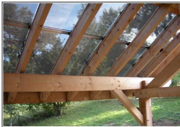
Installation de la toiture photovoltaïque
