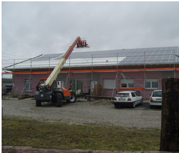
Chantier réalisé par ELECSOL, chantier en centre-alsace, fourniture FR énergies.
