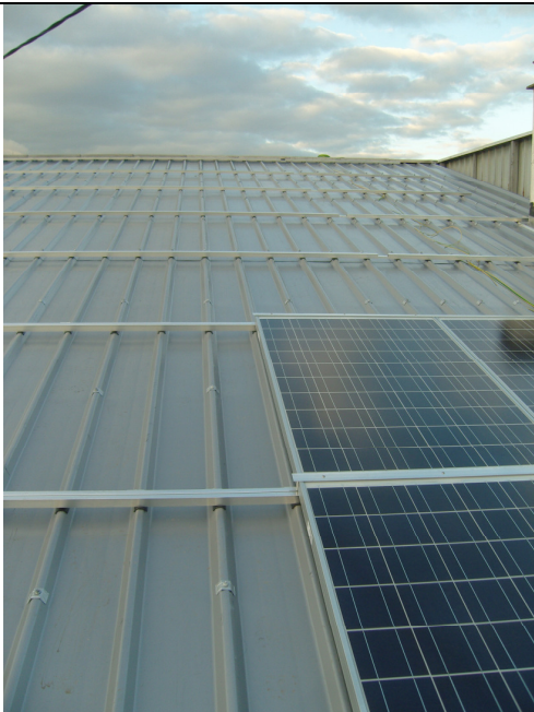
Chantier réalisé par Groupe Vincentz, sur toiture d'un garage, fourniture FR énergies.
