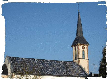
Chantier réalisé par la société EIE67, fourniture FR énergies sur l'église de Leutenheim
