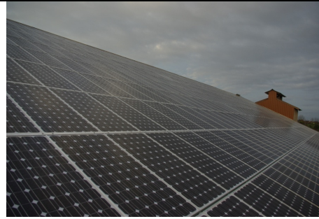
Chantier réalisé avec ECOTRAL ( filiale EDF) et SANTERNE ( filiale VINCI) et IMHOFF, fourniture FR énergies sur toiture agricole.
