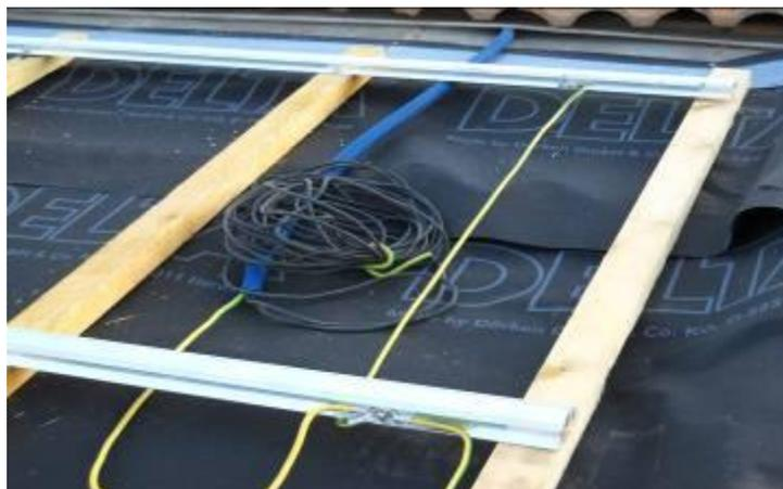
Pour la réalisation du chemin de câble électrique BT, il est important de préconiser l'utilisation de collier serre fils. Ces colliers sarong fixés sur les chevrons.
