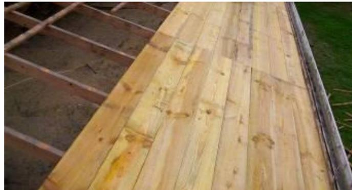
Ces planches de volige serviront de support à l'écran de sous-toiture et permettront de se déplacer plus facilement et de travailler plus aisément au cours de la pose des modules solaires photovoltaïques.
