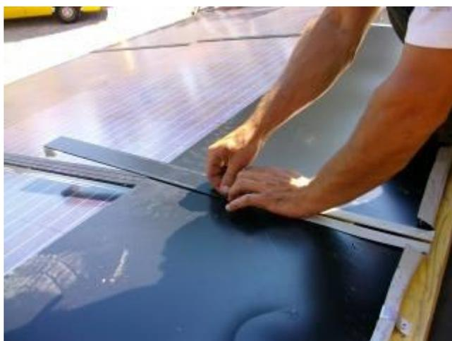
Dans les coins, les tôles d'abergement haut droite et gauche, veillez à rapprocher au maximum les tôles aux profilés de bordure latéralement, pour éviter une entrée d'eau. Disposez au mieux les tôles
