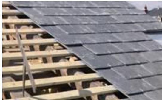
Retirer tous les linteaux sur la partie dédiée au champ solaire. Si une planche de rive est fixée en partie basse de la charpente, la conserver. Ces linteaux doivent être arrêtés au niveau d'un milieu de chevron et non entre deux chevrons. Si la couverture ardoise est posée sur un plancher de voliges, le conserver pour fixer le champ solaire (voir plus loin, pas de pose des planches de volige à effectuer).
