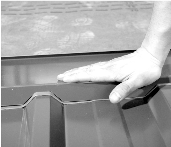
Fig. 27 Placez la capote supérieure en appuyant bien sa partie crantée dans le joint butyle de la fig. 24 Collez une bande plate de joint butyle dans les zones de recouvrement des capotes supérieures.
