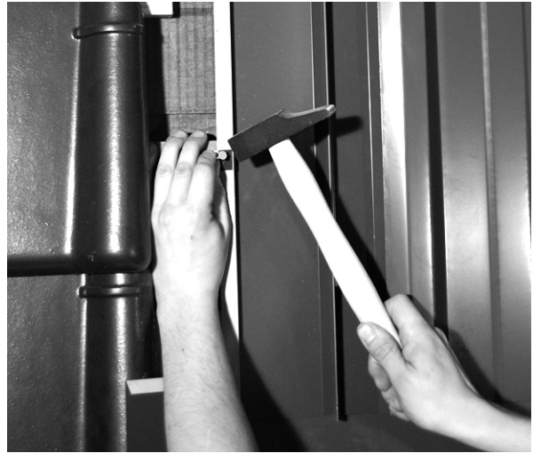
Fig. 16 Positionnez le canal latéral gauche le long du trait. Dans le sens du rampant, laissez-le recouvrir d'environ 5 cm le closoir inférieur. Une fois mis en place, fixez-le à l'aide des clous et languettes fournis.
