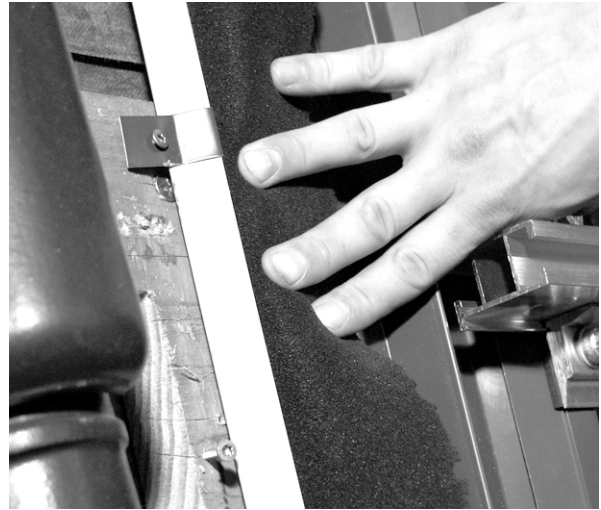
Fig. 28 Placez les mousses anti-neige autocollantes le long des plis écrasés des canaux et des capotes supérieures.
