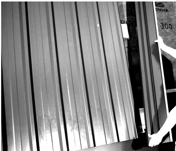
Fig. 19 Positionnez les bacs acier InterPV du premier rang de module. Respectez le nombre d'ondes total (cf. Annexes ou logiciel InterPV Soft ) en jouant sur les recouvrements. Conseils : si le vent ou l'inclinaison de toiture est important, vous pouvez fixer provisoirement les bacs en utilisant une vis autoforeuse dans les 2 cm du haut du bac.
