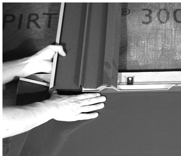
Fig. 11 Positionnez le closoir inférieur sur la bavette et fixez-les à l'aide des languettes.
