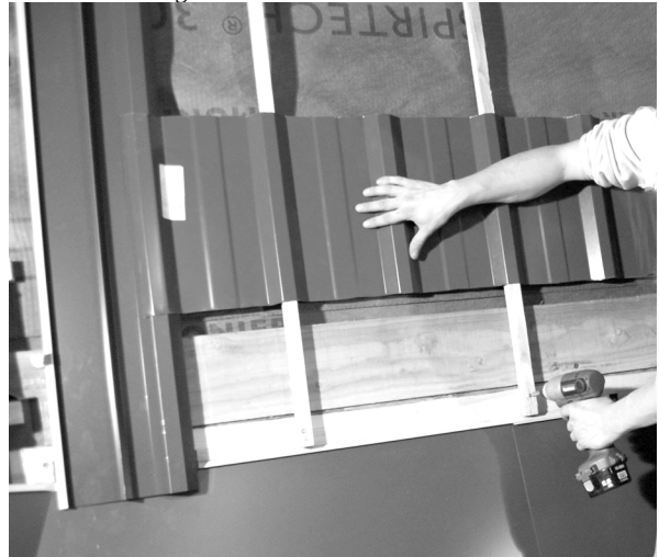
Fig. 18 Placez une latte de bois toute les deux ondes et à chaque recouvrement de bac. De plus prévoyez deux lattes consécutives aux deux extrémités. Pour positionner correctement les lattes, aidez-vous du gabarit de montage.
