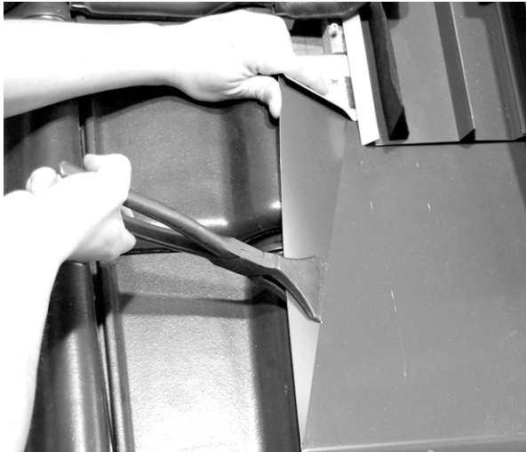
Fig. 17 Plier le coin de la partie en tôle de la bavette gauche. Utilisez pour ce faire une pince plate.
