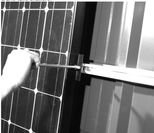
Fig. 31 Installez les modules en partant de la rangée inférieure. Dans le sens du rampant, centrez-les sur les rails B et C. Pour les centrer dans le sens du faitage, positionnez le premier module à une distance D_{\text{rail}} du bord du rail (cf. annexe pour SANYO et Schott ou logiciel InterPV Soft pour tout autre module)
