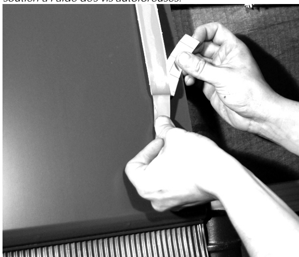
Fig. 12 Collez une bande de joint Butyle sur l'extrémité de la bavette en place.
