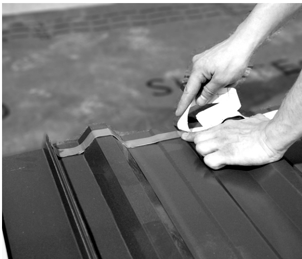
Fig. 25 Collez le joint butyle plat au cordeau à 30 mm du haut des bacs acier InterPV de la rangée supérieure.
