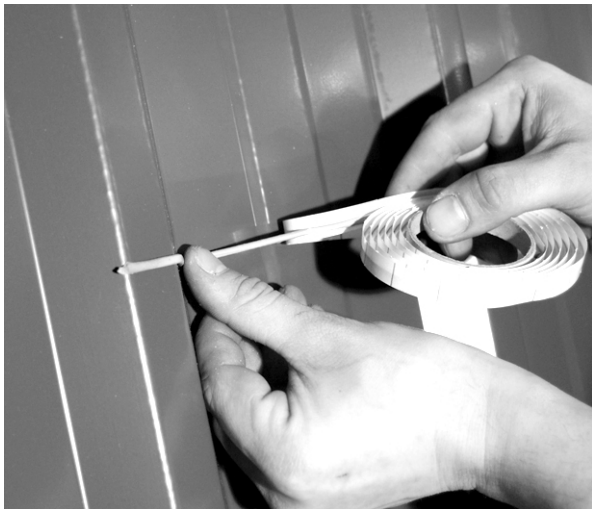
Fig. 23 Collez le joint butyle en forme de boudin sur le sommet des bacs acier InterPV
