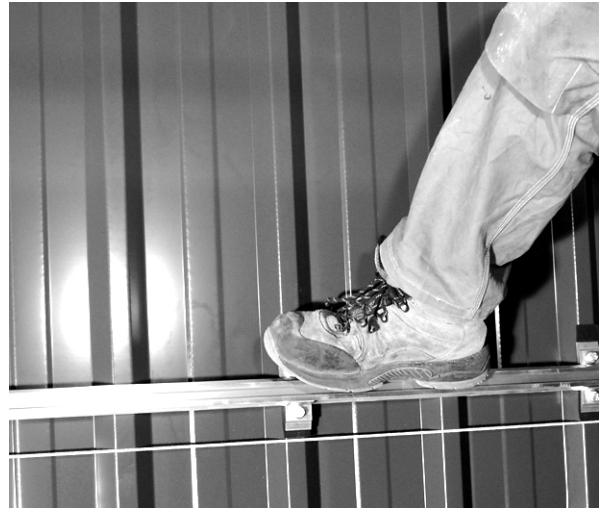
Fig. 22 Pour faciliter vos déplacements sur le toit, vous pouvez maintenant marcher sur le rail B.
