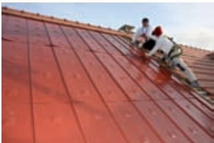
1. La pose des tôles de couverture
