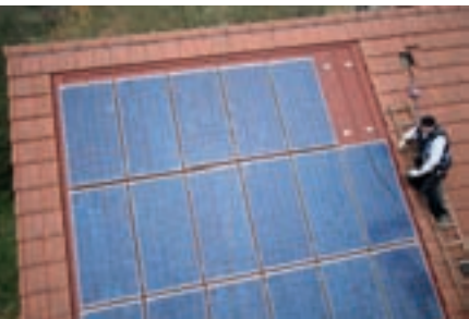
3. Le placement des modules
