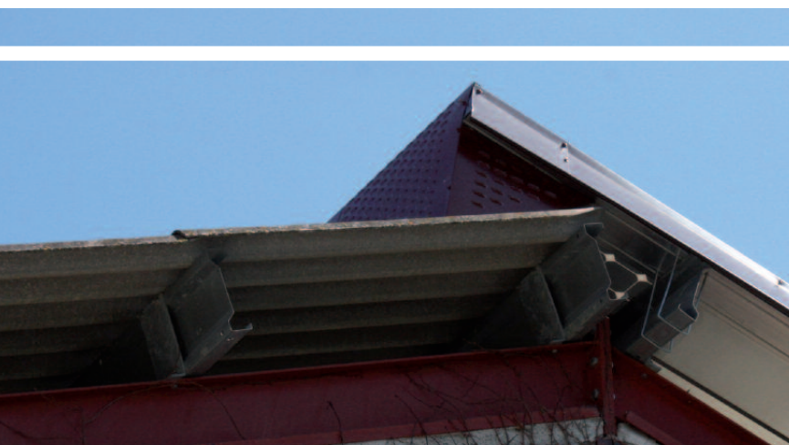
Faitière avec vanelles de ventilation.
