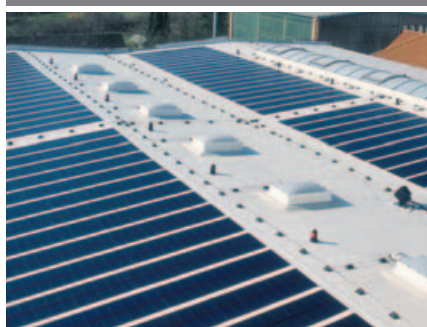
▲ FKT Kunststoffwerk, Triptis, Germany
