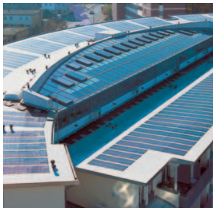
▲ BG Wiederaufbau, Braunschweig, Germany
