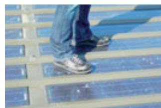
Circulation possible en toiture avec les précautions d'usage
