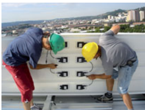
Boitier de connection et câblage
