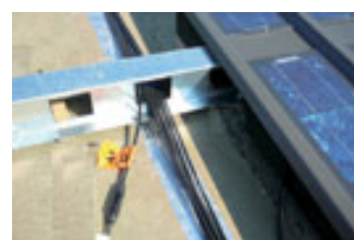
Passage de la câblerie dans les écarteurs ARSOLAR
