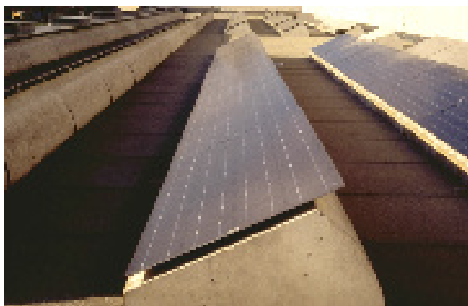
Figure 69 : Bâtiment DMX ; EPFL Lausanne, Suisse
