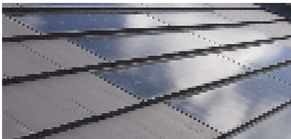
Figure 113: Vue d'ensemble d'une toiture avec la tuile SolarCentury
