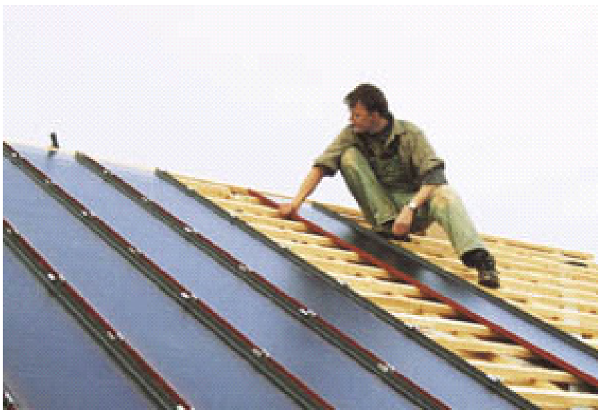
Figure 68 : Montage de panneaux Solartec type Design (modules souples UNISOLAR)
