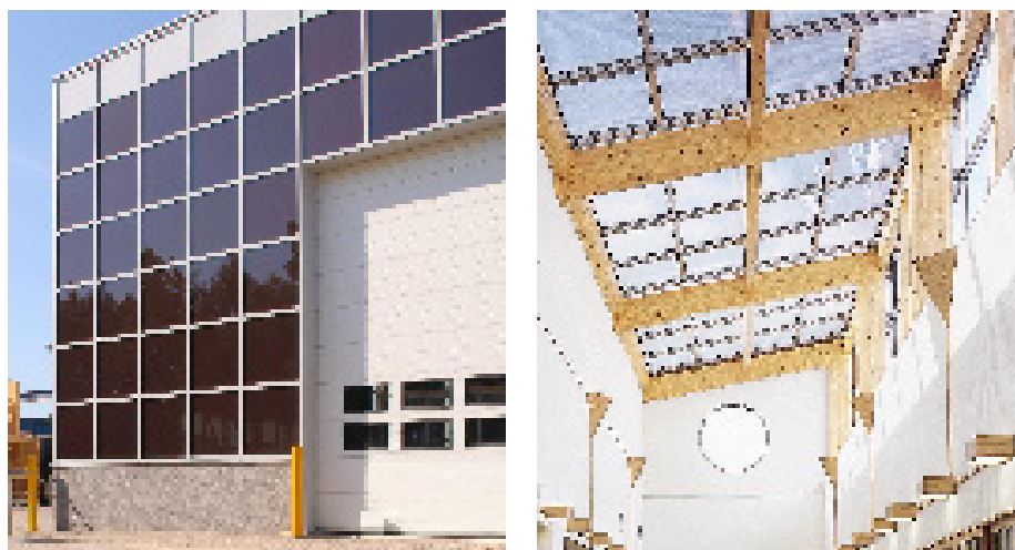
Figure 94 : Exemples d'intégration de modules MSK en façade et en verrière
