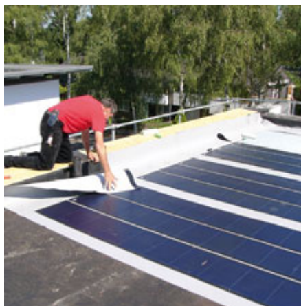
Figure 86 : Pose de la membrane Biosol PV (donnée constructeur Centrosolar)
