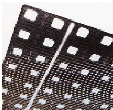
Figure 92: Détail des modules translucides de Systaic
