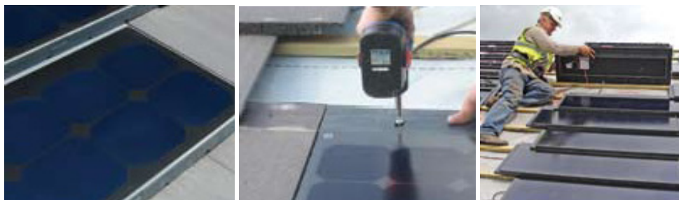
Figure 112: Détails du montage des tuiles SolarCentury
