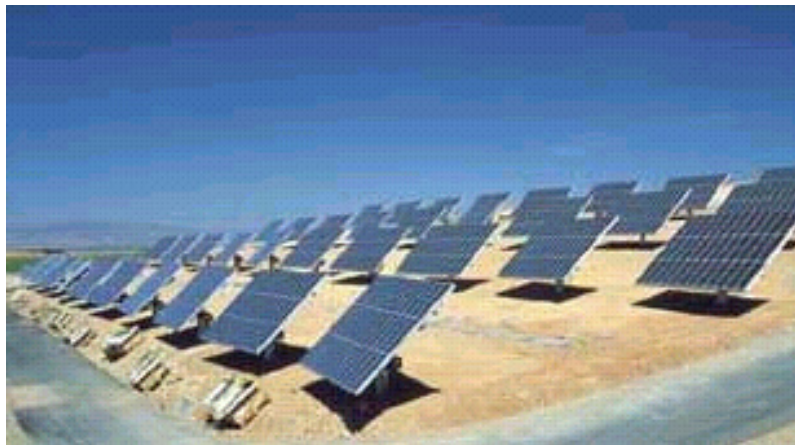
Figure 60 : Centrale de Tudela en Navarre
